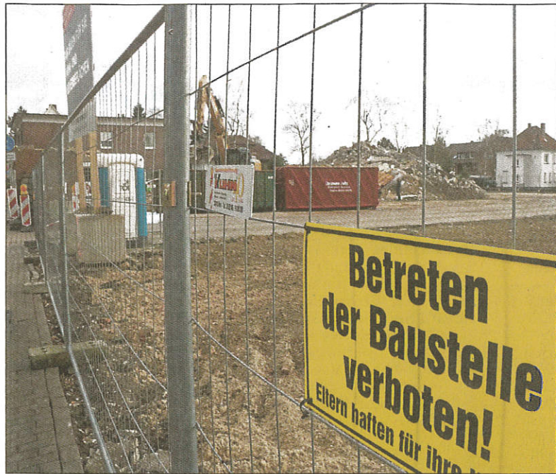
Veränderte Ansicht: Die Abräumarbeiten auf dem ehemaligen Gelände der Spedition Titgemeyer sind fast abgeschlossen. Am Dienstag räumte der Bagger das Haus an der Carl-Bertelsmann-Straße 30 ab.
